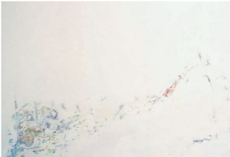
Detail der „Mur poncé“ (Sandgestrahlte Wand)
