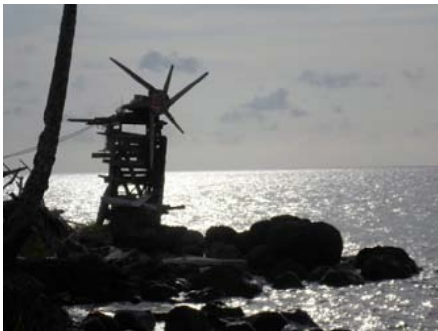
Abendstimmung auf Little Corn Island, mit Stromgenerator Marke Eigenbau
