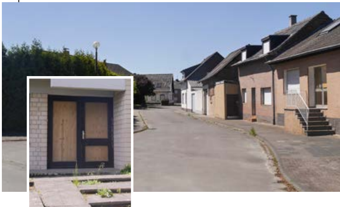
Gespensische Ruhe in Mannheim: Pressspanplatten verdecken die Fensterscheiben, Bauzäune versperren die Hofeinfahrten. Foto: Paul Nachtwey
