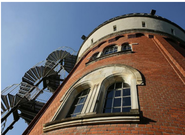
Früher diente der Turm der Wasserversorgung von Lokomotiven. Foto: Mülheim Tourismus
