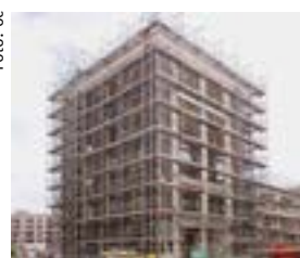
Notfalls wird das Vogelgezwitscher vom Band kommen: Baustelle Grafental
